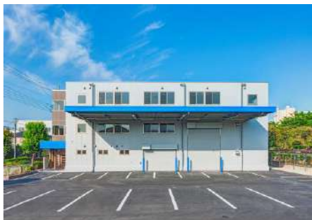
事務所・倉庫/鉄骨造3階 889㎡
