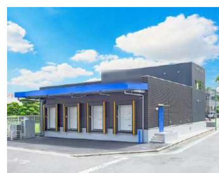
事務所・倉庫/鉄骨造2階 375㎡
